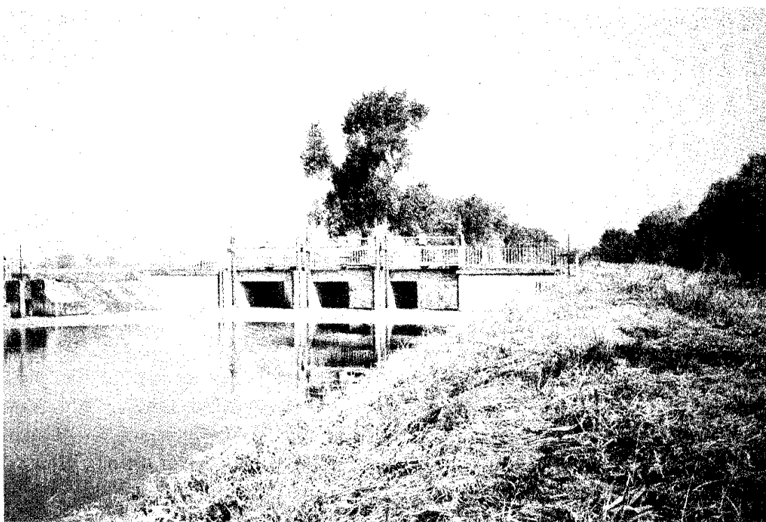
Jazo-most na Mosińskim Kanale Obry w rejonie Bonikowa wybudowany w 1981 r.
