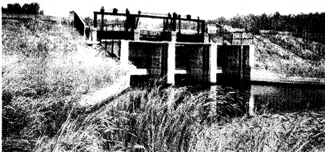
Zapora czołowa wraz z budowlą upustową na Zbiorniku Wonieść.
